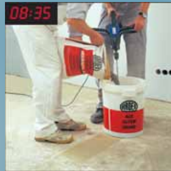
8 點 35 分 以機械攪拌方式拌合 ARDEX K55 超快乾鎖水 自平泥。
