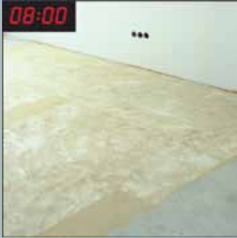
夜間 8 點 進場，拆除舊有飾面
